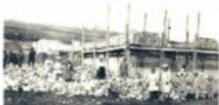
La Chiesa in cantiere
