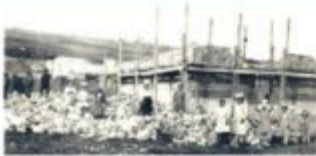
La Chiesa in cantiere
